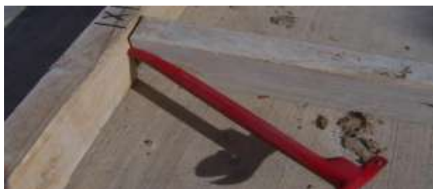
Aligning a twisted stud
